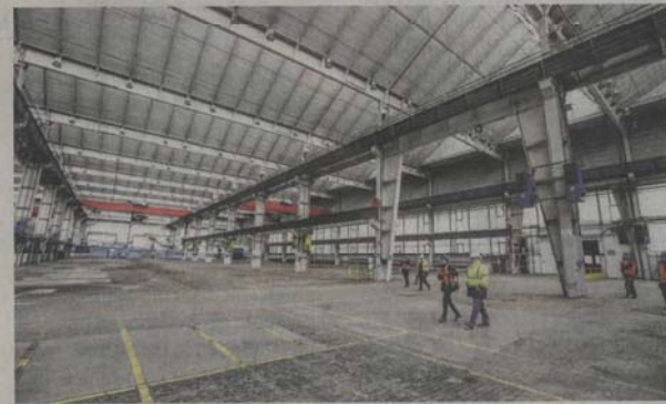
Diese Opel-Produktionshalle muss noch zurückgebaut werden. FOTO: ANDRÉ HIRTZ
